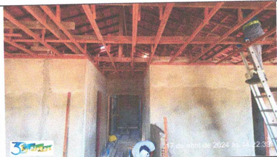
Foto 11: Reboco e tarugamento de forro
