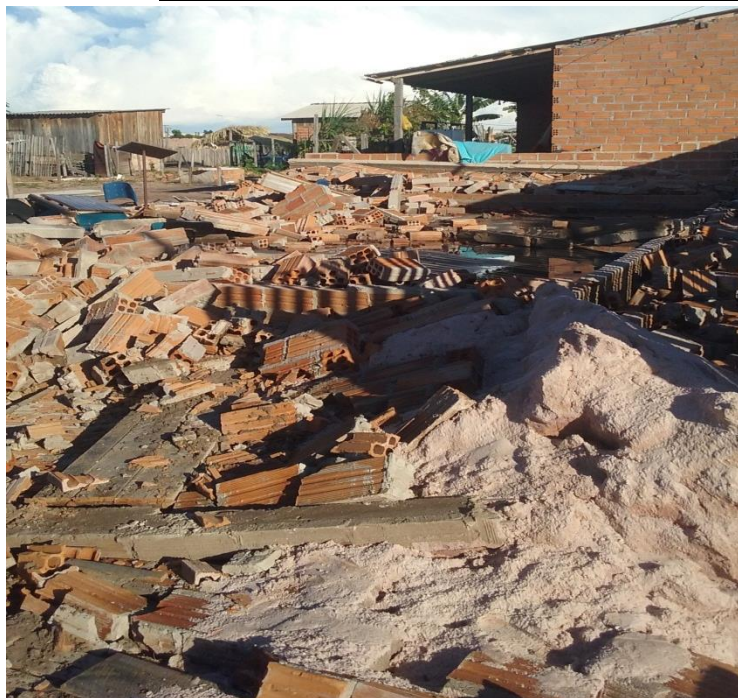
LEGENDA: Igreja destruída na rua 04 s/n, bairro de Planalto.
