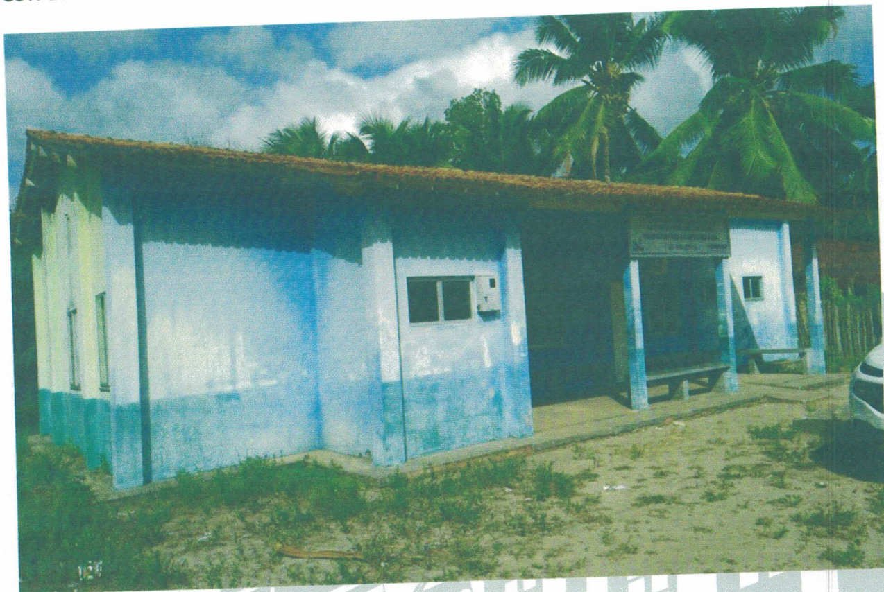
Reg. fotográfico da situação-Engenharia e Fiscalização/SEMUSB/PMB
