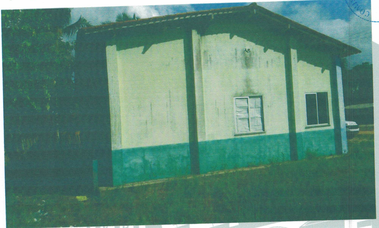
Reg. fotográfico da situação-Engenharia e Fiscalização/SEMUSB/PMB
