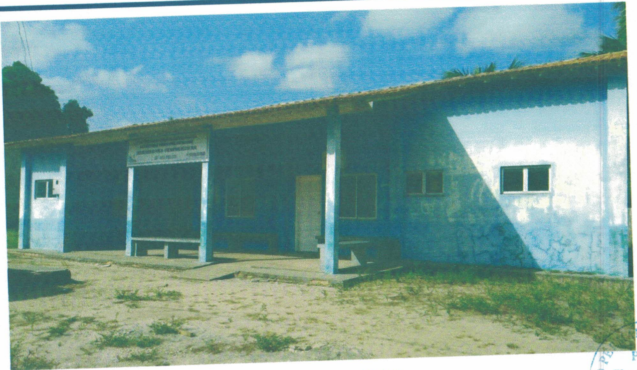
Reg. fotográfico da situação-Engenharia e Fiscalização/SEMUSB/PMB
