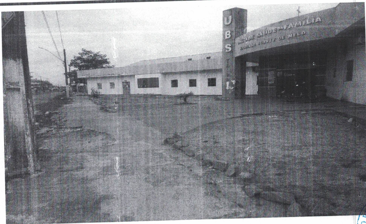
Reg. fotográfico da situação-Engenharia e Fiscalização/SEMUSB/PMB
