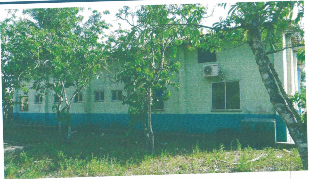
Reg. fotográfico da situação-Engenharia e Fiscalização/SEMUSB/PMB
